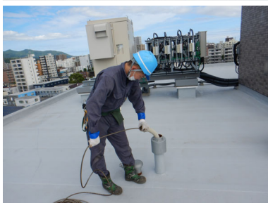
③屋上通気から立管洗浄
