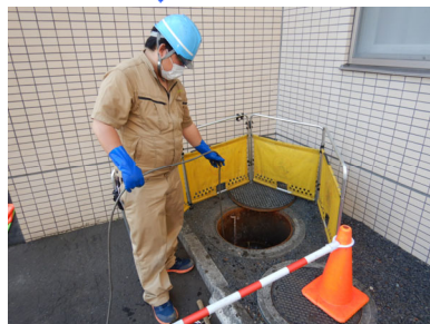
①屋外排水管
